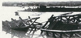
昭和9年7月洪水 太田橋被災状況
