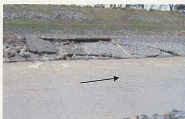
堤防護岸決壊及び根固めの流出
