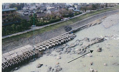
堤防護岸決壊及び根固めの流出
